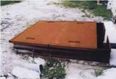
作業等の清掃時の汚水を外部に流出させない為の排水留です。汚水はモーターによってミミズ畑に散布します。
